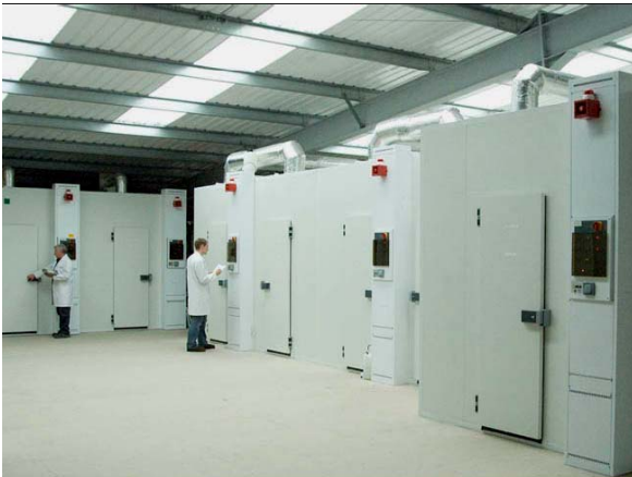
Fig.4 Ensemble de chambres froides pour les microfilms de la British Library
